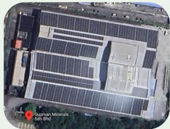
Planta de Malasia 1.123 kWp
